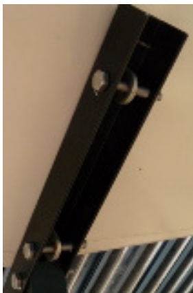
Detalle unión anclajes
