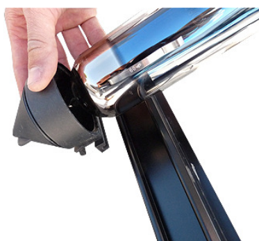
Colocar el soporte inferior para el tubo
